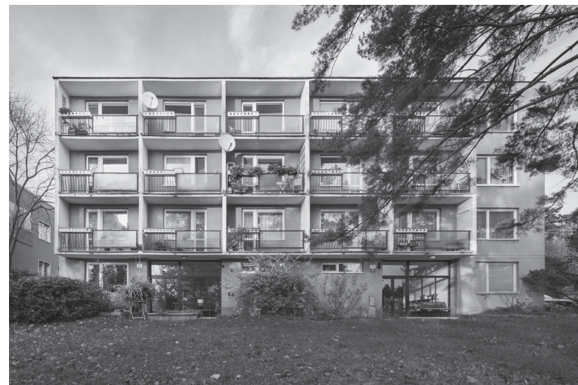
Experimentální dům z litého betonu, později replikovaný na území Brna pod názvem „typ Zounek“, Brno – Pisárky, Vinařská 40–42, projekt: František Zounek a Viktor Rudiš, 1958, realizace: 1959, hlavní průčelí, současný stav. Foto: Zdeněk Porcal, 2014
