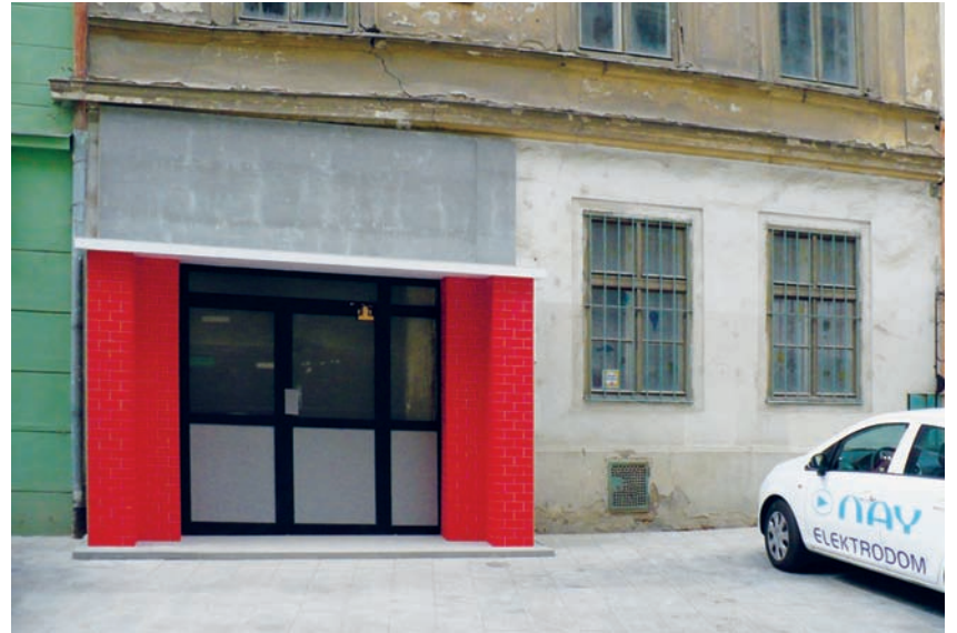
Portál, 2009, v rámci výstavy Sochy v ulicích, Brno, foto: archiv Tomáše Džadoně
